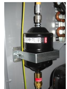
Рис. 48 – Фильтр-осушитель
