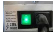
Figura 4 - Presa per corrente
